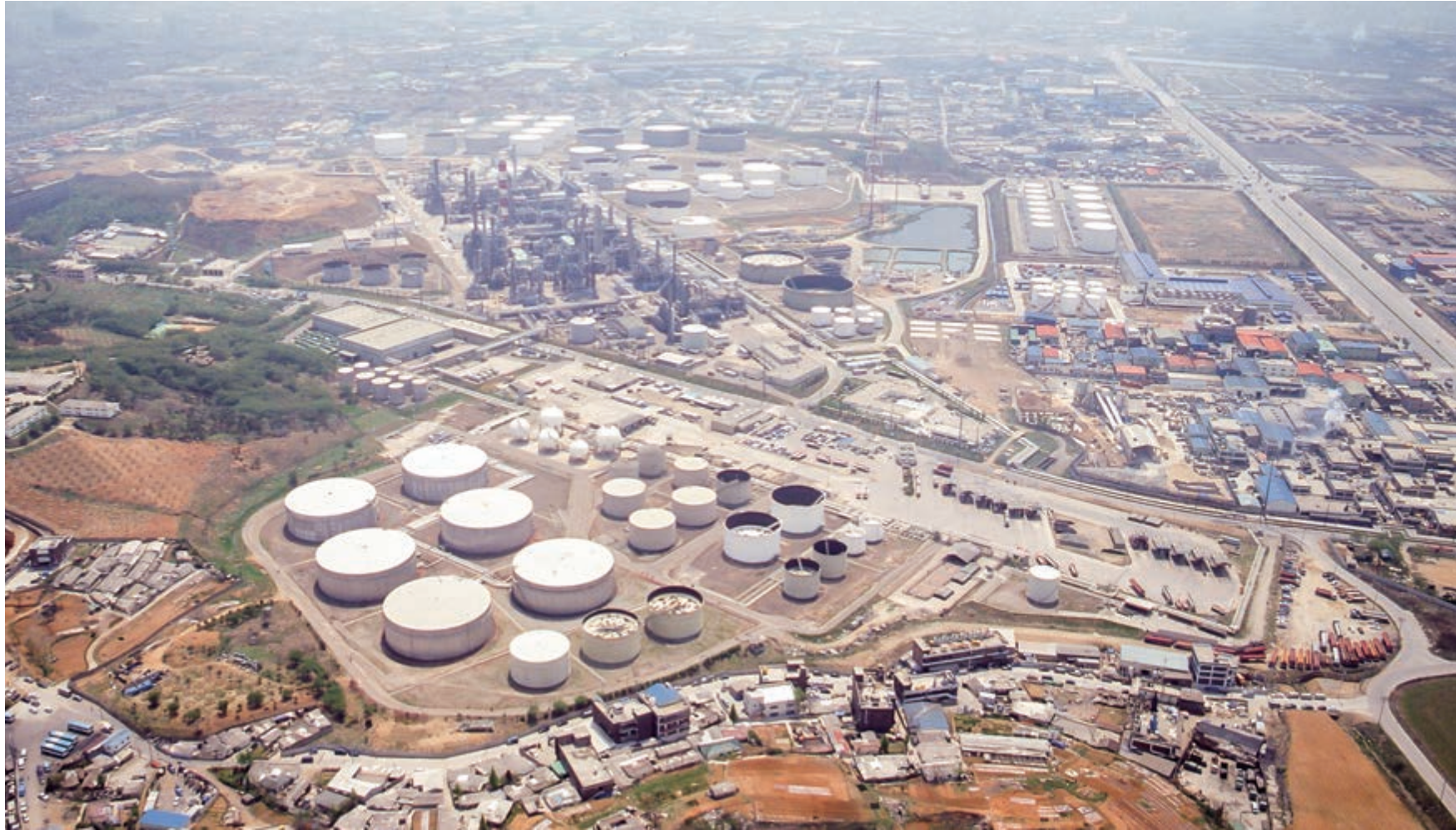
인천 한화에너지공장 전경
